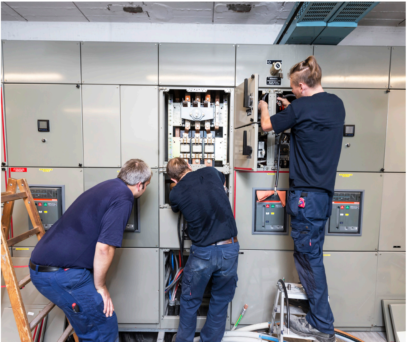
Service på spændingsløs tavle.
